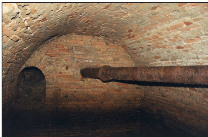
FIG. 1 - Interno dell'ipogeo ritrovato sotto la pavimentazione di piazza Sant'Andrea, con la tubazione dell'acquedotto comunale posta in opera nel 1928. (fotografia Simone Piaser).
