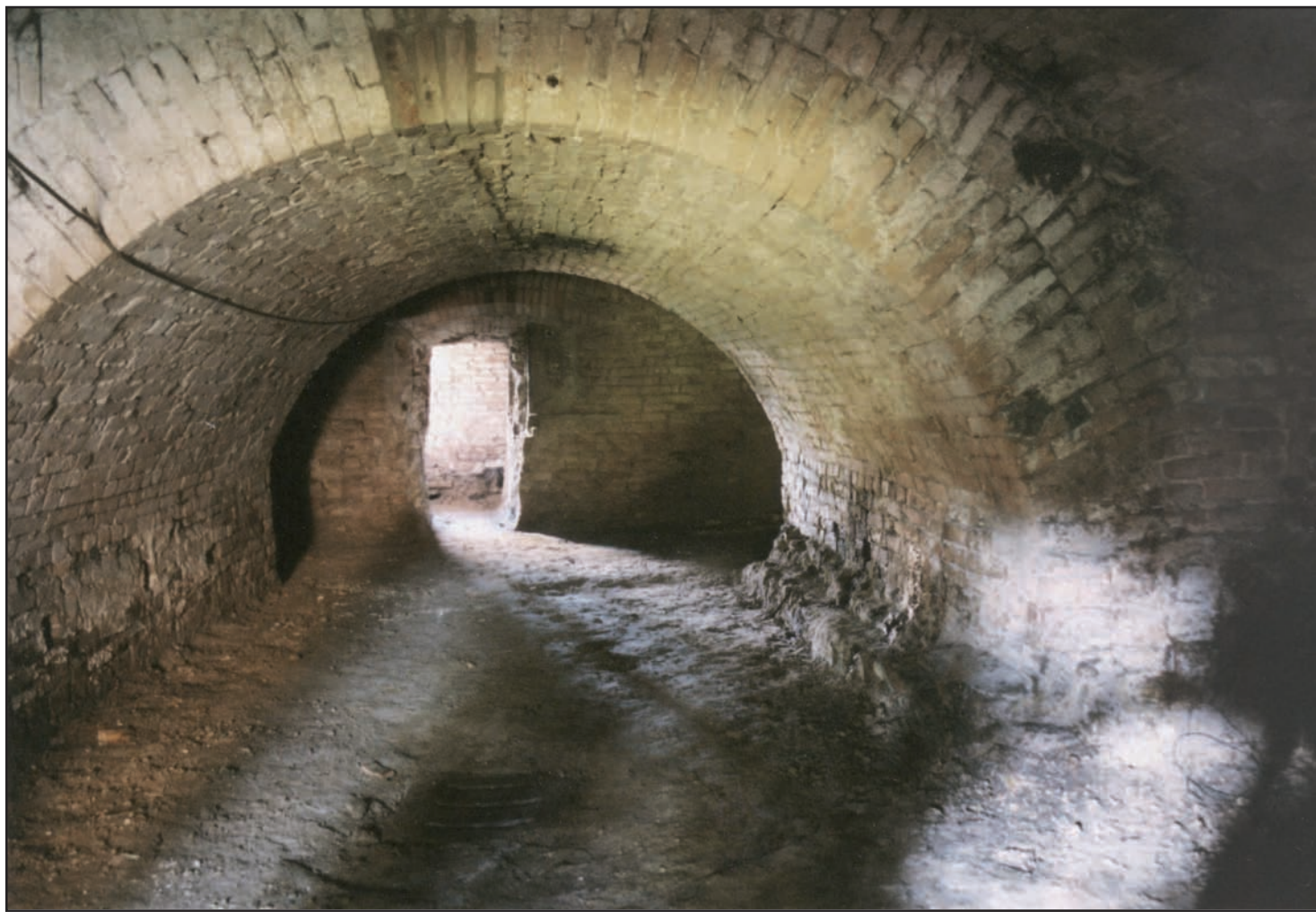
FIG. 9 - Interno della casamatta di porta Santi Quaranta, coperta con una semplice volta a botte priva d'intonaco. (fotografia Simone Plaser).
