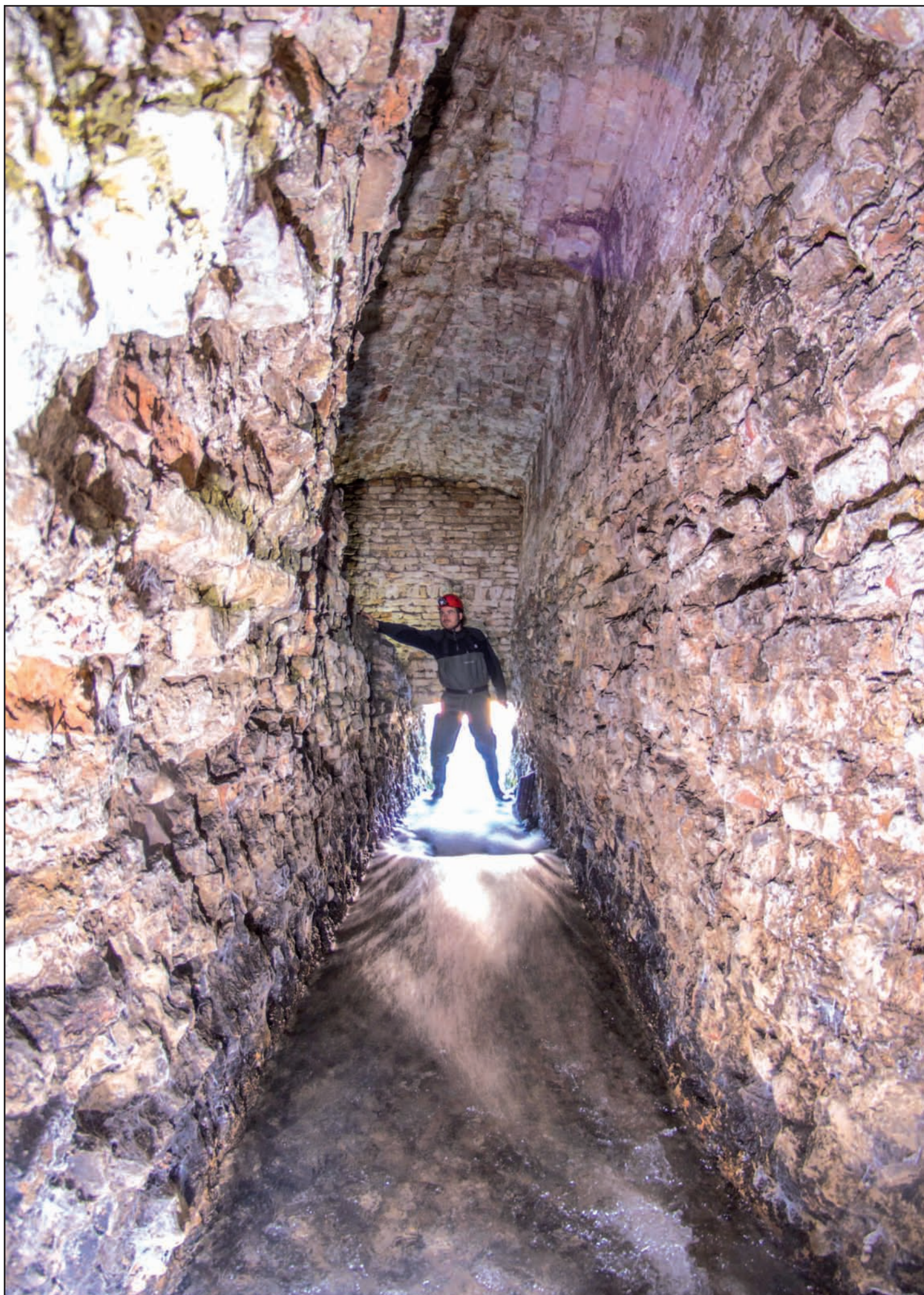
FIG. 13 - Ingresso del cunicolo sotterraneo ricavato alla base dell'originaria cannoniera nord del bastione di Santa Sofia. (fotografia Milo Stocco).
