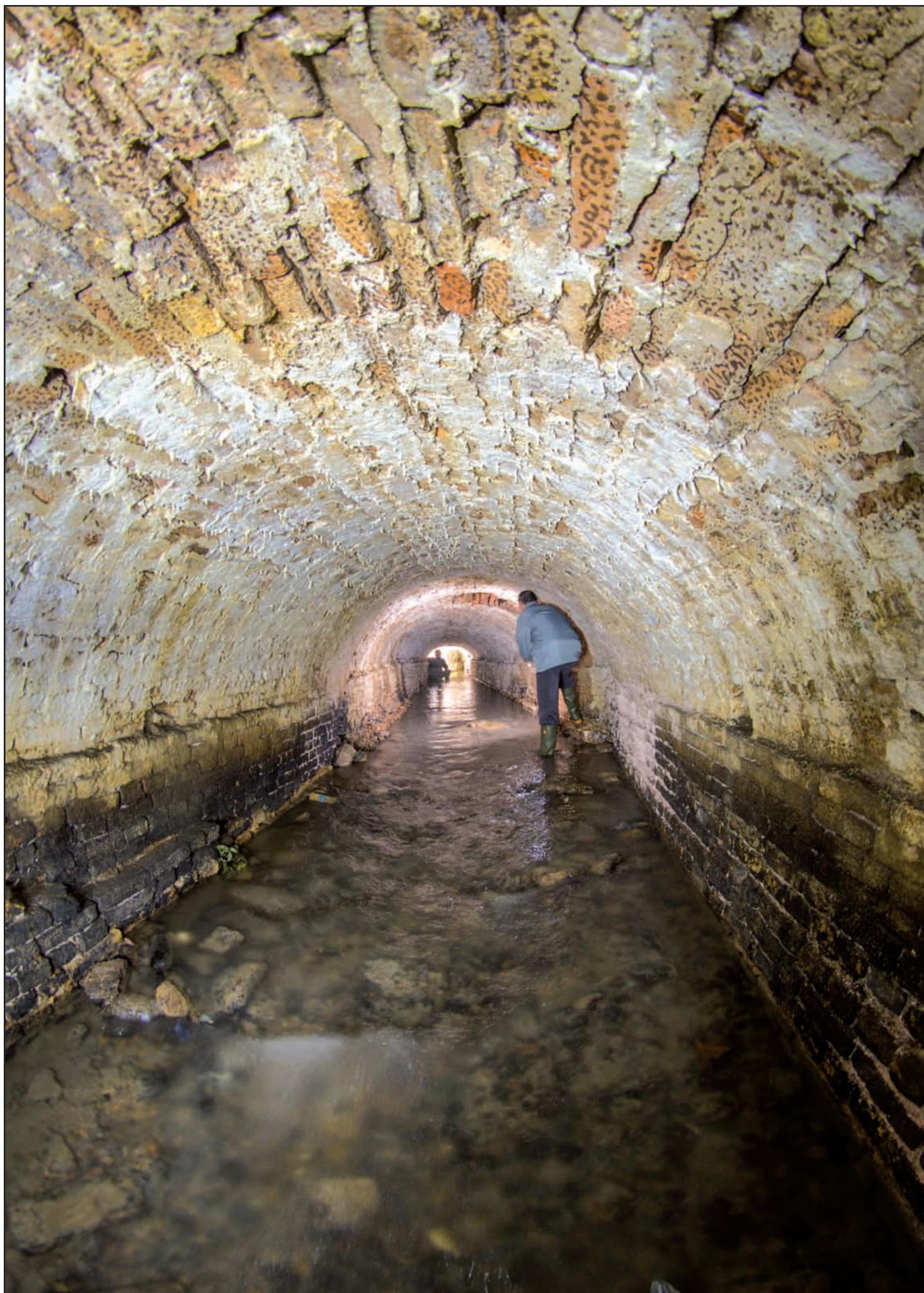
FIG. 14 - Tratto di epoca rinascimentale della lunga galleria passante sotto il terrapieno delle mura e comunicante con il torrione di Santa Sofia. (fotografia Milo Stocco).
