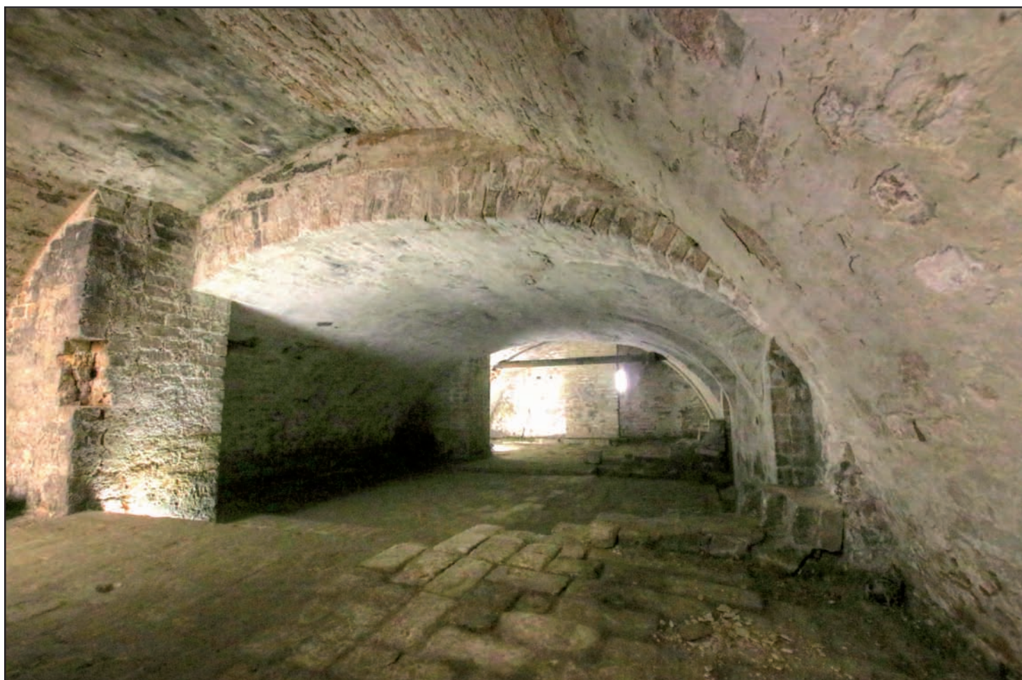
FIG. 8. - La casamatta di porta San Tomaso, con i vani riservati allo scorrimento delle catene per la manovra dei ponti levatoi, carralo e pedonale. (fotografia Aurelio Valentini).
