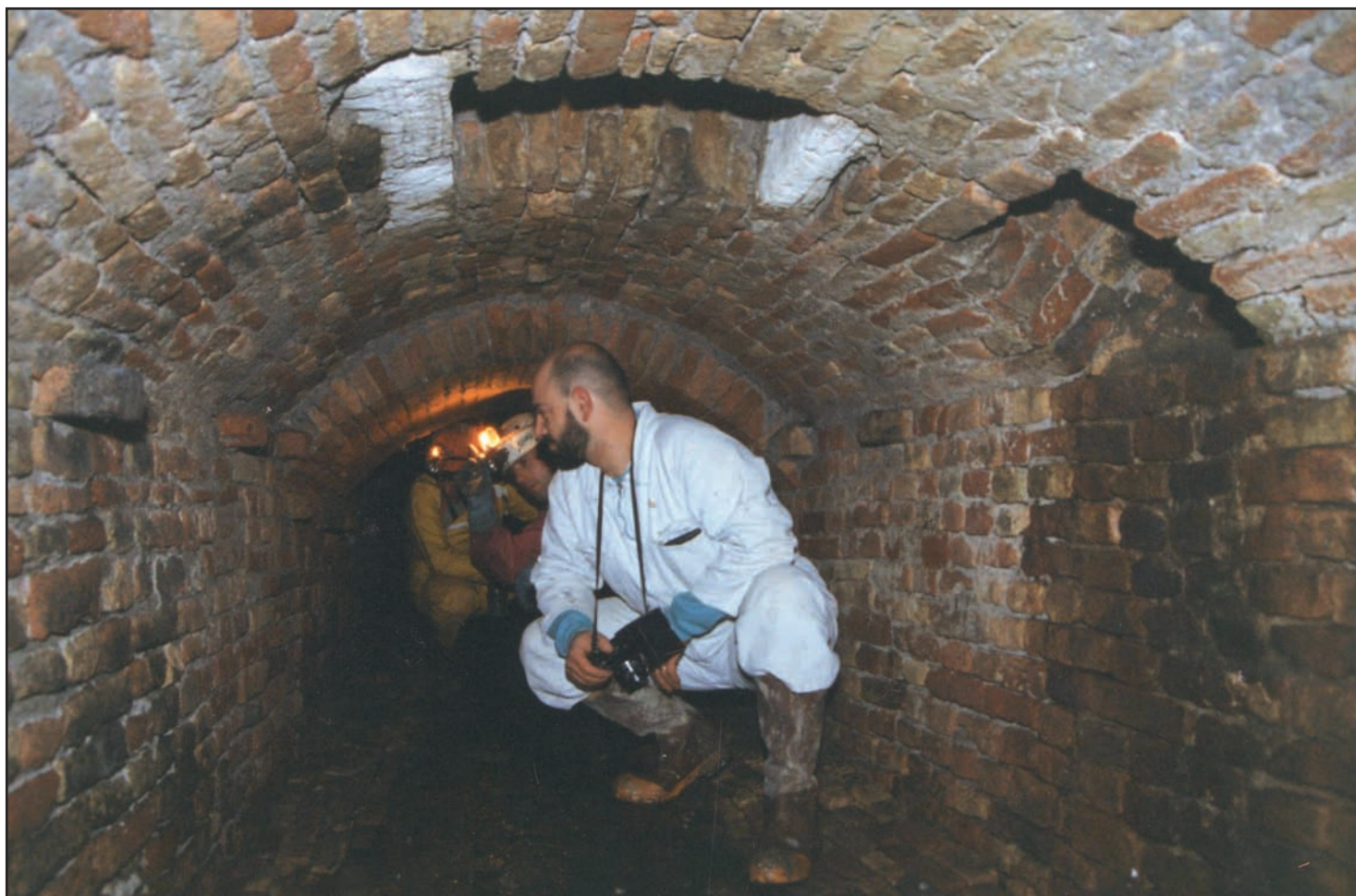
FIG. 3 - Interno del cunicolo rinvenuto in corrispondenza del lato est delle antiche carceri austro-ungariche, dietro l'ex tribunale, in piazza Duomo. (fotografia Simone Plaser).
